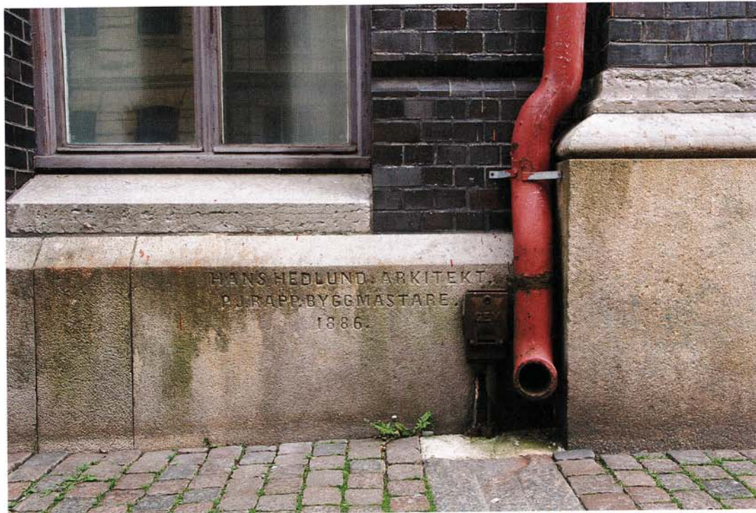
FIGUR 6. Schillerska gymnasiet (i i Fig 1) har en sockel i Bohusgranit mot gatan. På denna står det inhugget att huset uppfördes 1886. Dock är detta inte helt rätt ty sockelstenen finns i en utbyggnad från 1911. Man har således flyttat på sockelstenen, troligen för att den inte skulle bli gömd. FOTO: Erik Sturkell.
