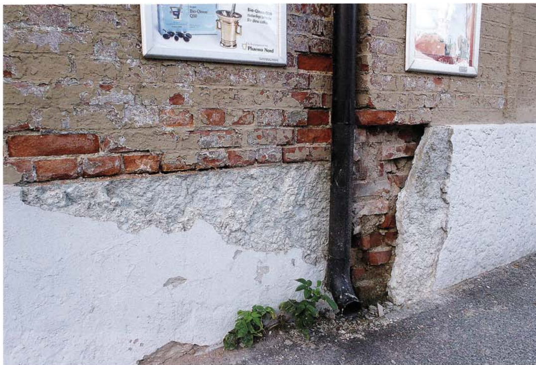
FIGUR 7. Landshövdingehuset vid Kapellplatsen (k i Fig. 1), byggt 1887, har en grå ortoceratitkalksten som sockel. Kalkstensblocken står på högkant vilket medfört en ödesdiger vittring. Särskilt sker detta om kalken är mörk (lerig). Man har målat kalkstenen, troligen för att skydda den, dock har det inte hjälpt i detta fall. Kalkstensytornas karakteristiska textur går här att urskilja bakom den tunna målningen. FOTO: Erik Sturkell.
